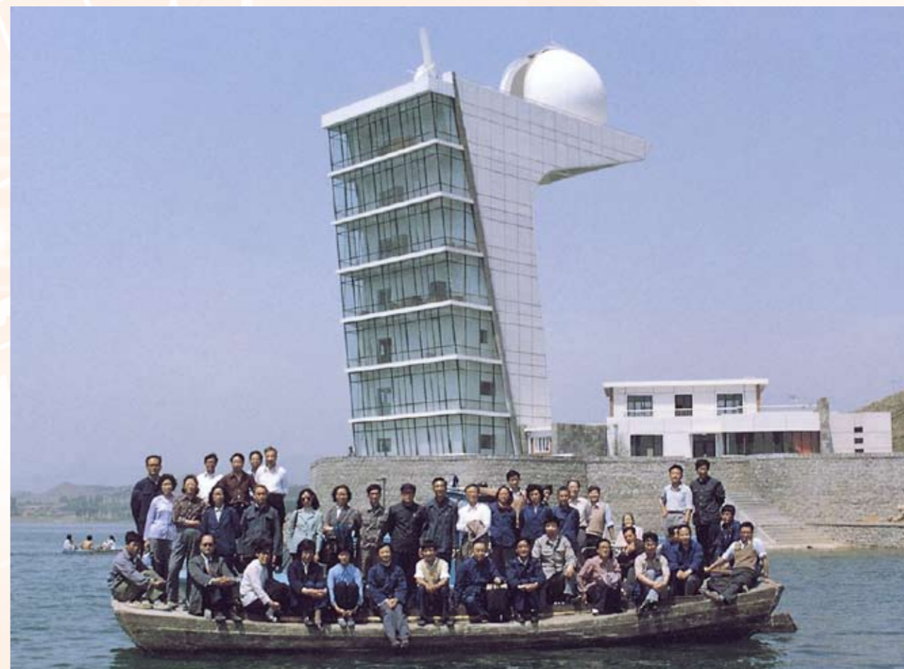
太阳观测塔楼终于矗立起来了！建设者们欢聚在为建站同样立下汗马功劳的大木船上合影留念。塔楼依旧在，木船知何处？
