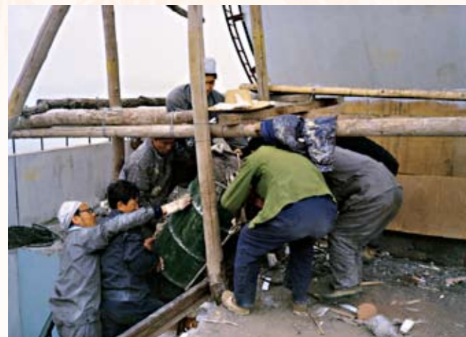
人拉肩扛，一桶桶施工材料就是这样被抬上塔楼的楼顶
