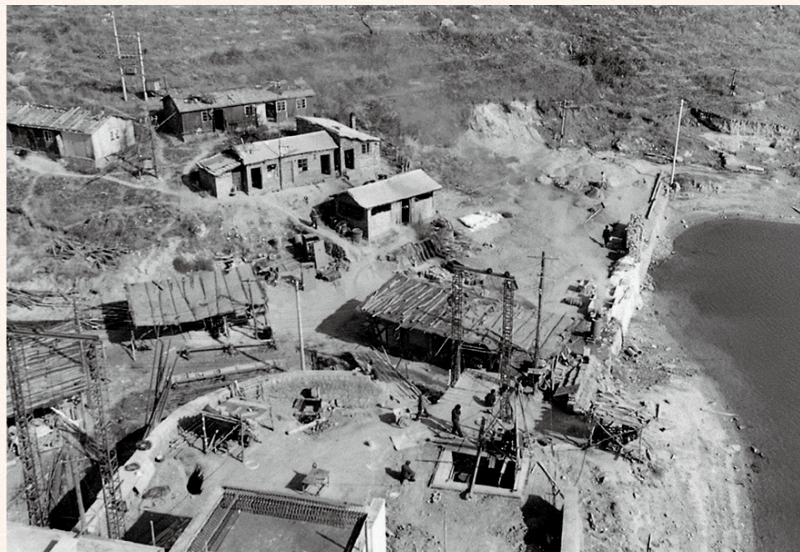
1982年破土动工的怀柔太阳观测基地
